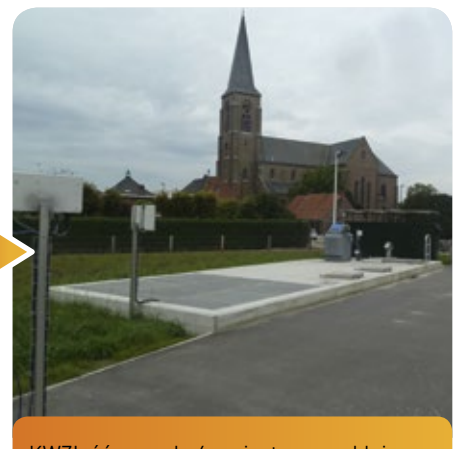
KWZI, één van de 4 projecten voor kleinschalige waterzuivering KWZI via Aquafin werd gebouwd.
